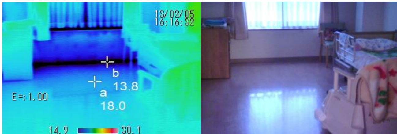
既存建築物 個室(非導入室)
