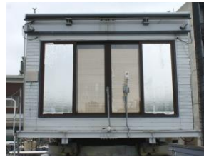
図1 屋上実験棟写真
