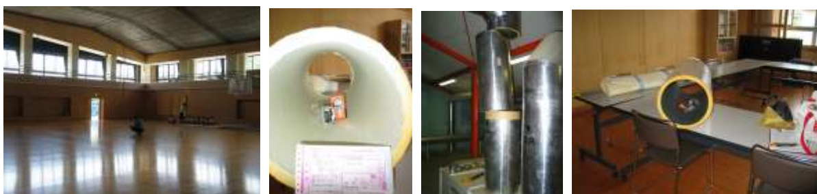
写真 8. 同施設 室内 写真 9～11. OM ダクト交換の前・交換中・交換後 (線量に変化無し)
