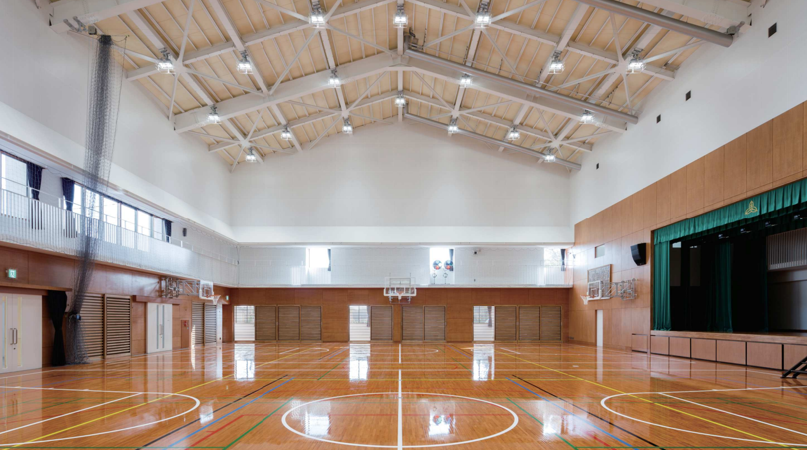
体育館内観。屋根勾配に沿ってOMソーラーのダクトが見える。
