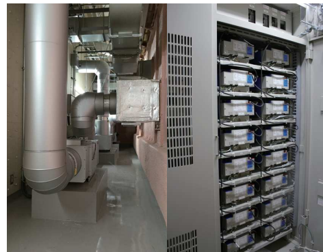
左 / 自立運転型OMハンドリングユニット 右 / リチウムイオン蓄電池
