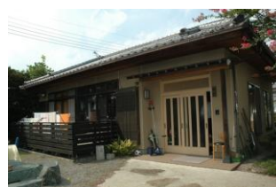
写真-1 建物外観
